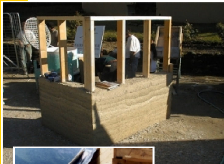
Démonstration de chanvre banché sur ossature bois à ECOTECH 2002 F. LELONGE
