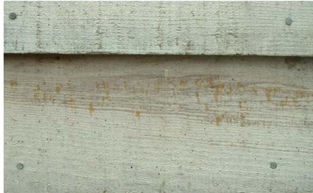
Écoulements de résine, bardage en pin noir avec traitement de surface, photos Proxylon, 2003
