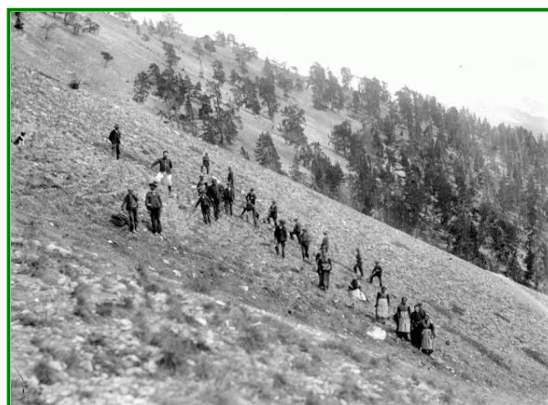
Chantier de boisement fin 19 ème siècle (Arvieux – Hautes-Alpes) – Archives RTM
