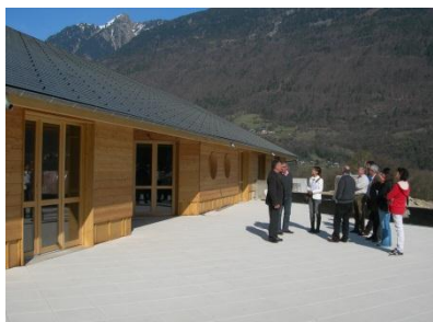
Ecole de Saint Rémy de Maurienne (73), construite en Bois des Alpes
