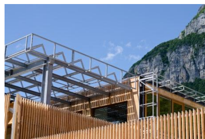
Bâtiment multifonctionnel de Saint Jean d'Arvey (73) construit en Bois des Alpes
