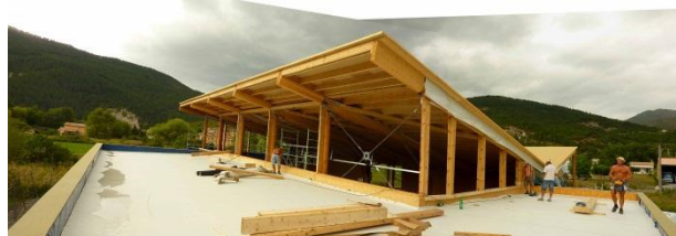
Atelier bois à Barrême (04), construit en Bois des Alpes
