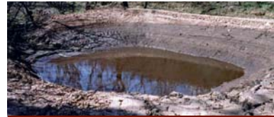
Décantation des sédiments dans le bassin, qui peu à peu se colmate (Rémy Bonnasse, Syndicat Intercommunal de la Giscle).
