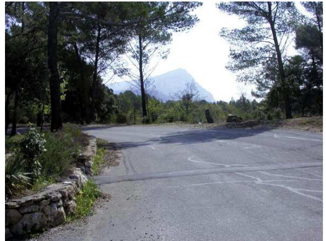
Après débroussaillage voirie commu-
