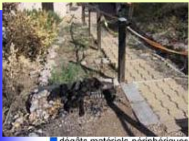
dégâts matériels périphériques
