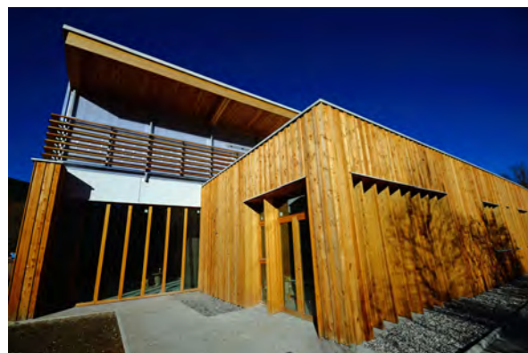
Source : Atelier Bois de Barrême - P. Cook 2012
