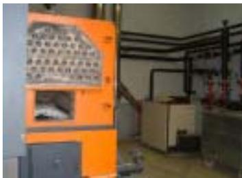
L'installation comporte une chaudière d'une puissance de 550 kW (*photo ci-contre*) alimentant un réseau de chaleur, installés en 2001.
