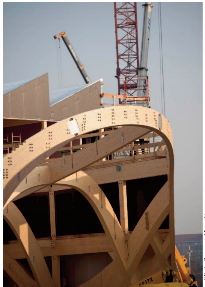
Construction du pavillon France à Milan pour l'exposition universelle de 2015
