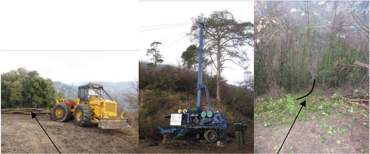
Le tracteur et le câble Mât (Griefenberg) de l'entreprise Belmon sur la place de dépôt (Menton, février 2010)
