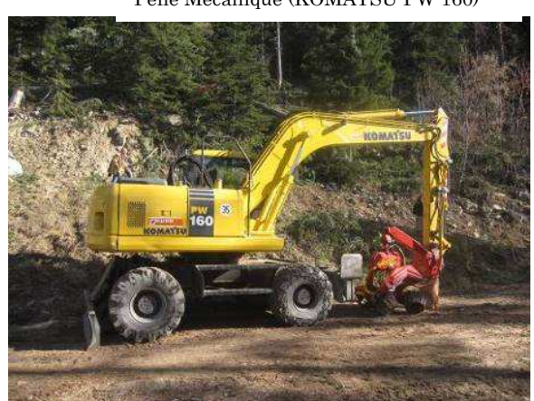
Pelle Mécanique (KOMATSU PW 160)
