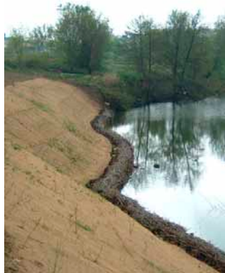
Restauration de berges par plantation et fascinage avec des Saules
