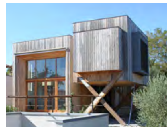
Construction en bois apparent; Source : Architectes Paillet-de Besombes
