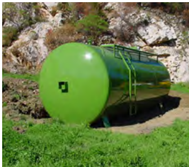
Intégration paysagère d'une citerne DFCI; Source : Service Forêt
