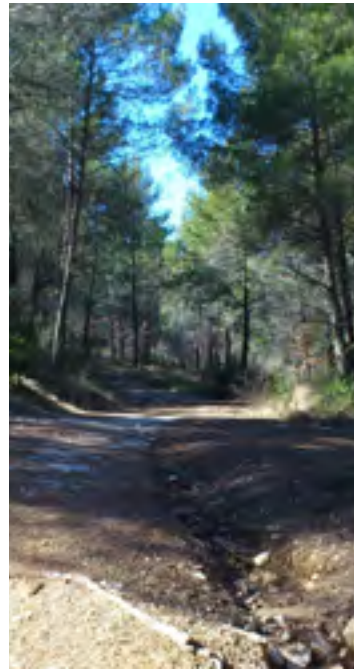
Voie dégradée; Source : Service Forêt
