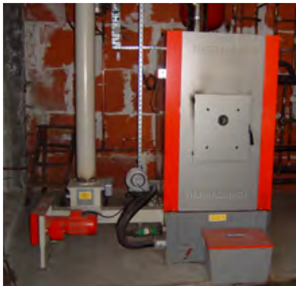
Chaudière bois; Source : Communes forestières 13
