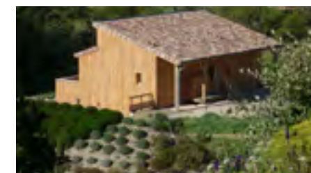
Construction à ossature bois à Aix-en-Provence; Source : Architectes Solari & Associés
