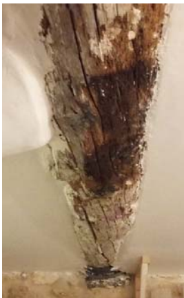
A gauche : Poutre de pin d'Alep dans un bâtiment ancien - L'Esquichette - Aix en Provence
