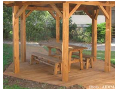
Pergola et aménagement extérieur en pin d'Alep traité autoclave Espagne – 2014 (réalisation et photo AIDIMA)
