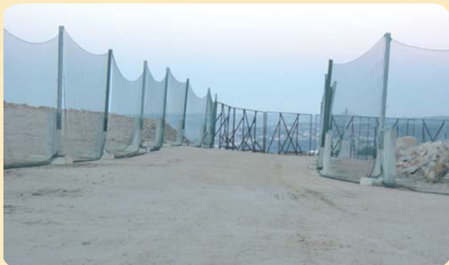
Procédure Grand Vent du site Véolia : mise en place de filets métalliques souples qui évitent l'envol de déchets vers le domaine forestier. Cet exemple est un cas particulier mais montre la mise en place de parade pour éviter la propagation d'incendie intra-site vers le domaine forestier.
