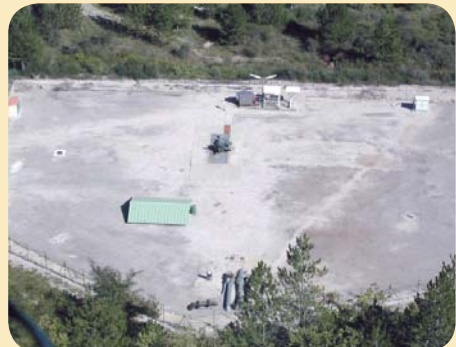
Isolément d'une tête de puits par rapport à la végétation environnante sur le site de Géométhane
