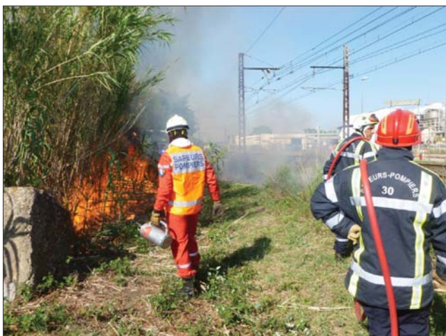
Opération réalisée avec le trafic de trains roulants (TGV, TER et trains de marchandises)
